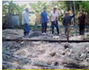
Le début des travaux
