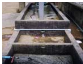
Les lavabos existants
