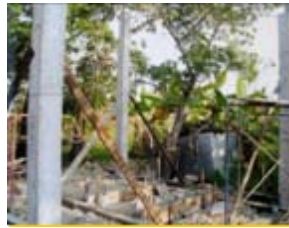
La pose des piliers porteurs
