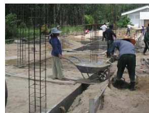
Début des travaux
