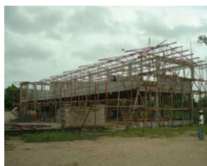
Progression des travaux - Juin 2006
